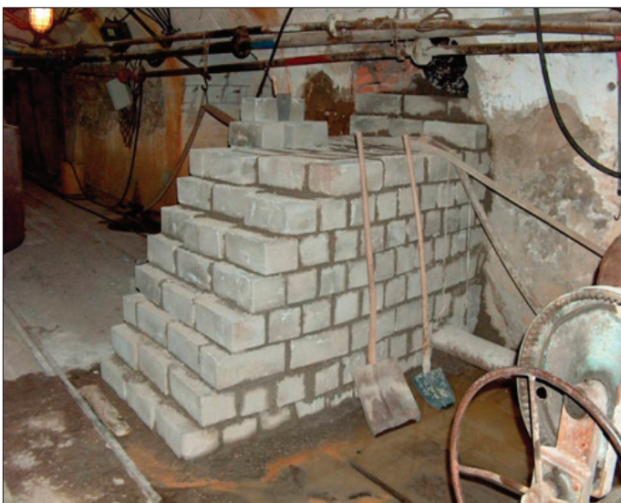
Obr. 4: Stavba hráze L 27.
