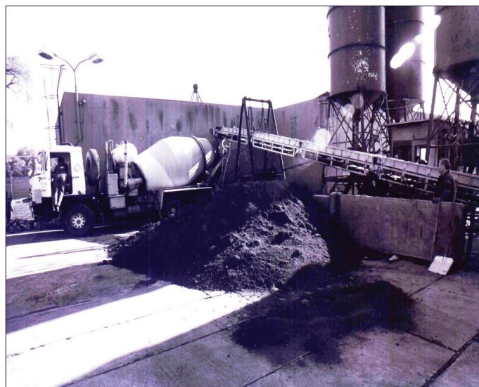
Obr. 6: Zásyp jámy Lb 2.
