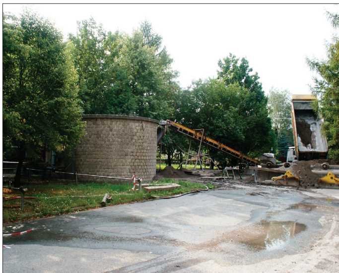
Obr. 5: Zásyp jámy K 2.
